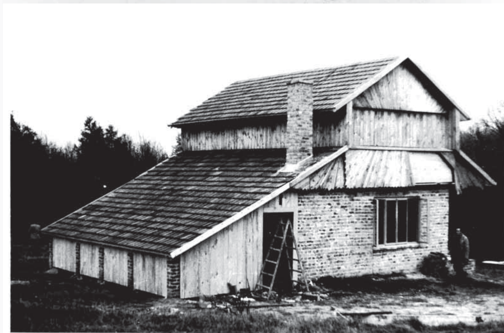
Osada myśliwska Koła w Woli Zgłobieńskiej – I faza budowy
